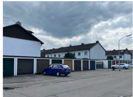
Abb. 22: Reihenhausbau mit Garagen
