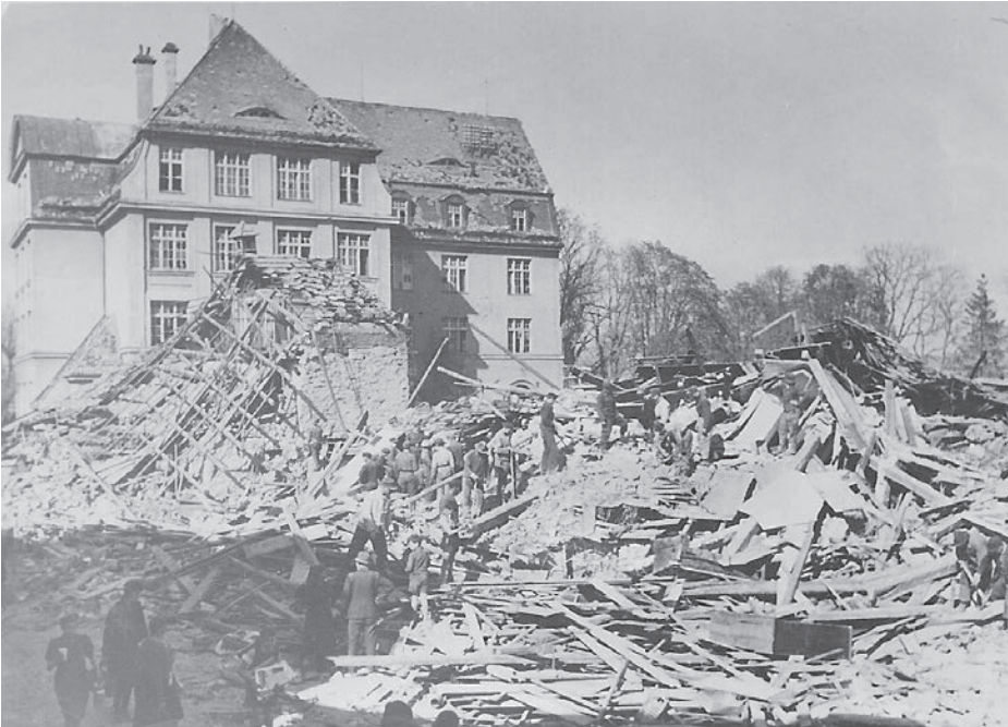
Blick auf zerstörte Häuser an der Haager Straße während der Verschütteten- und Opfersuche nach dem Luftangriff auf Erding am 18. April 1945. Im Hintergrund die damalige Knabenschule, heute Grundschule am Grünen Markt (Foto: Museum Erding/Archiv Foto Zeiler).
