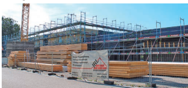
... und am Ludwig-Simmet-Anger errichtet.
