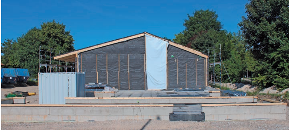
Zwei große Projekte in Sachen Kinderbetreuung werden aktuell in der Langen Feldstraße...
